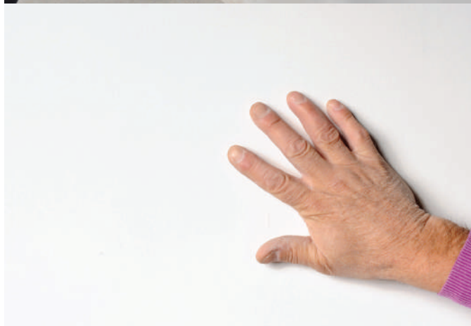
14. Per una "finitura liscia", si passa sulla parete una mano di rasatura applicata con la spatola corta utilizzando il Rasante P190 .
