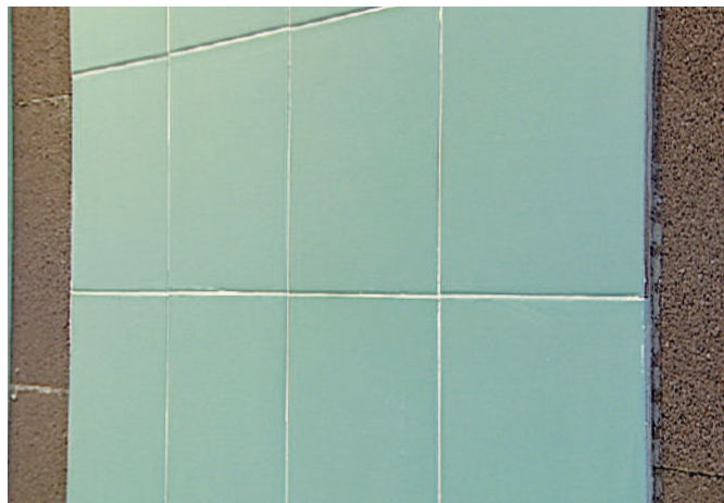
17. Le piastrelle vanno applicate direttamente sulla parete con i Collanti P120 - P180 - P300 .
