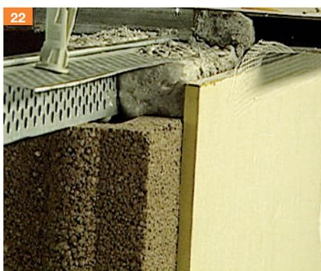
22. Dispositivo in profilato di acciaio (angolare a cerniera) per l'ancoraggio al soffitto.
