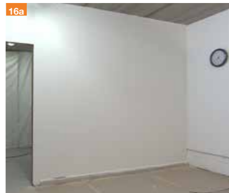
16a. Dopo la seconda mano di P180 si può procedere alla finitura delle pareti.
