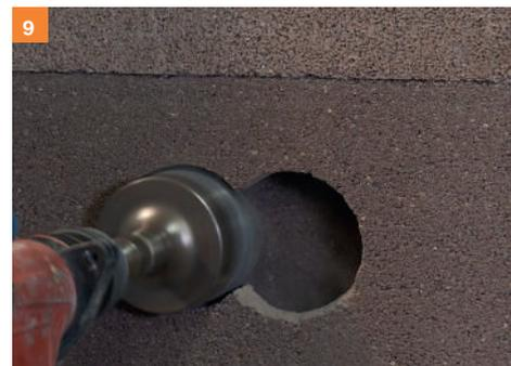
9. Foratura dei pannelli per l'inserimento delle scatole per l'impianto elettrico.
