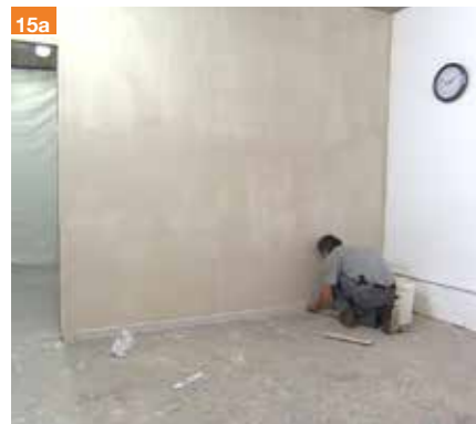
15a. Il battiscopa verrà incollato sempre con il Collante Rasante P180.
