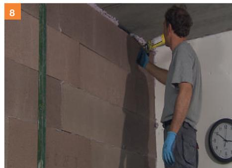
7-8. Stessa operazione di fissaggio avverrà in corrispondenza degli angolari a cerniera posti al soffitto. Con il collante Spidigliù verrà colmato lo spazio tra soffitto e parete su ambo i lati.
