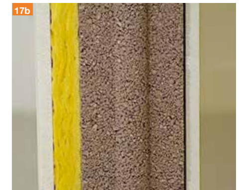
17b. Soluzione con lastra accoppiata con lana minerale e lastra standard per ottenere valori di 50 dB ed EI 180.
