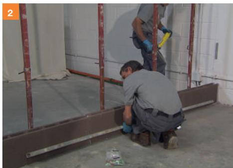
2. La posa del primo corso può avvenire direttamente sul pavimento con il collante Spidigliù oppure sul massetto del solaio grezzo con la Malta M330.
