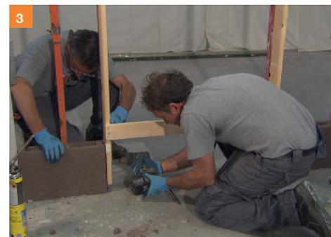
3. Fissaggio del contro telaio al primo corso di pannelli con le viti.
