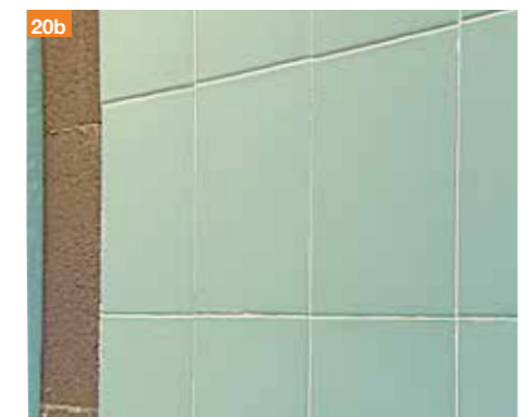
20b. Le piastrelle vanno applicate direttamente sulla parete Brik con i collanti P120-P180-P300.
