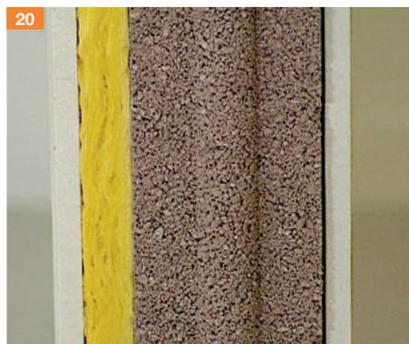
20. Soluzione con lastra accoppiata con lana minerale e lastra standard per ottenere valori di 50 dB ed EI 180.
