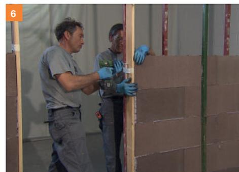
4-5-6. Il montaggio avviene alternando il senso di posa da sinistra verso destra e da destra verso sinistra ripetendo le operazioni di fissaggio del contro telaio ed alle strutture esistenti.
