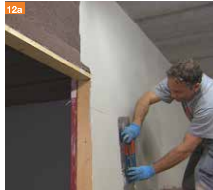
12a-13a Finita la posa ed effettuata la pulizia si procede subito alla rasatura delle pareti con il Collante Rasante P180 che va applicato con la spatola lunga in senso orizzontale sulla parete.
