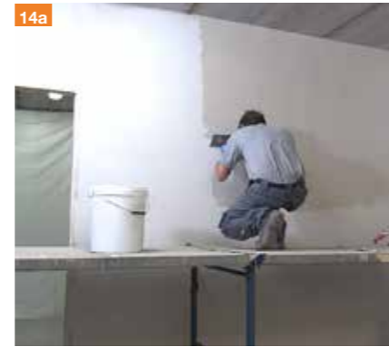
14a. Alla distanza di ca due ore dalla prima verrà applicata una seconda mano sempre con la spatola lunga in senso verticale.
