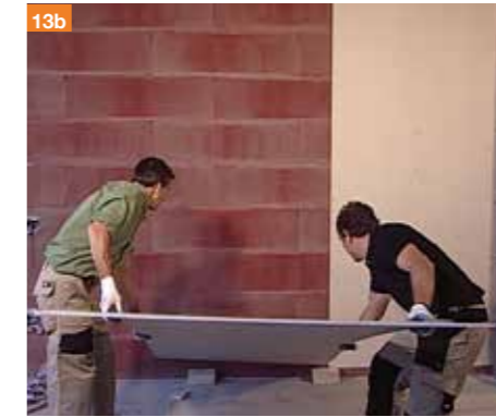
13b-14b. Applicazione delle lastre alla parete con il collante...
