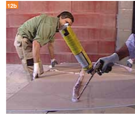
12b. Incollaggio della lastra in cartongesso con il collante Spidigliù.
