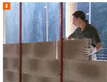
1.2.3. Il montaggio avviene con la posa del collante sui profili ad incastro con l'utilizzo dei collanti Prefedil a base cemento oppure può avvenire interamente con il **Collante Spidigliù**. Il collante si applica con la pistola erogatrice.
