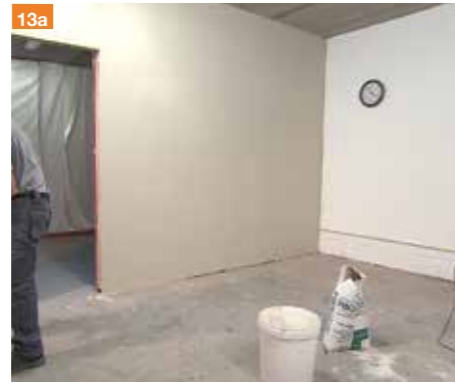
12a-13a Finita la posa ed effettuata la pulizia si procede subito alla rasatura delle pareti con il Collante Rasante P180 che va applicato con la spatola lunga in senso orizzontale sulla parete.
