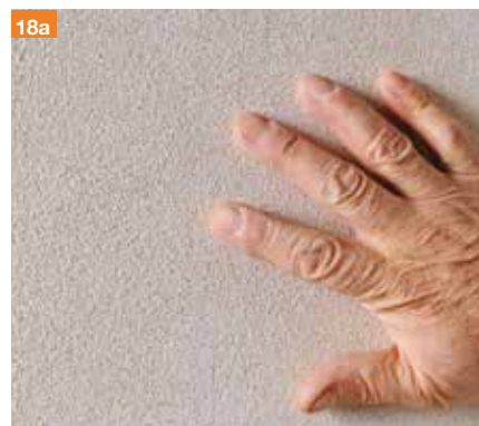
18a. Si può ottenere una finitura tipo "a civile" applicando una seconda mano con il rasante P180 sulla prima mano e verrà rifinito con il frattazzo a spugna prima dell'indurimento.
