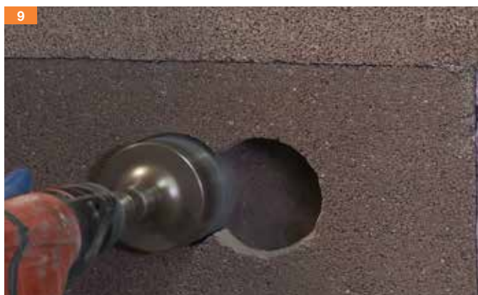
9. Foratura dei pannelli per l'inserimento delle scatole per l'impianto elettrico.
