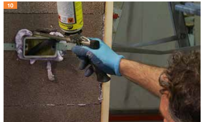
10. L'inserimento e fissaggio dei corrugati e delle scatole degli impianti.
