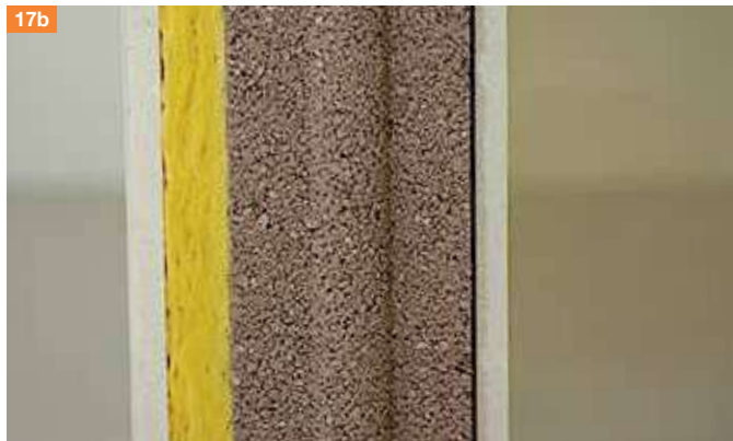
17b. Soluzione con lastra accoppiata con lana minerale e lastra standard per ottenere valori di 50 dB ed EI 180.
