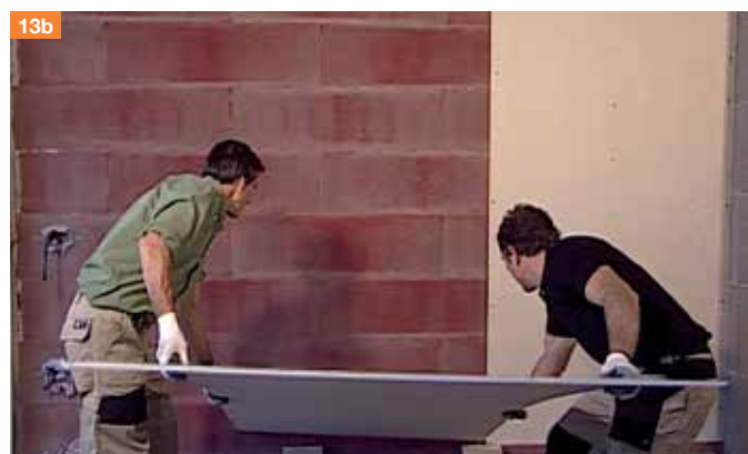
12b. Incollaggio della lastra in cartongesso con il collante Spidigliù. Applicare strisce di colla alla distanza di circa 30 cm una dall'altra.
