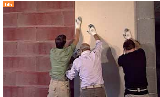
13b-14b. Applicazione delle lastre alla parete con il collante...
