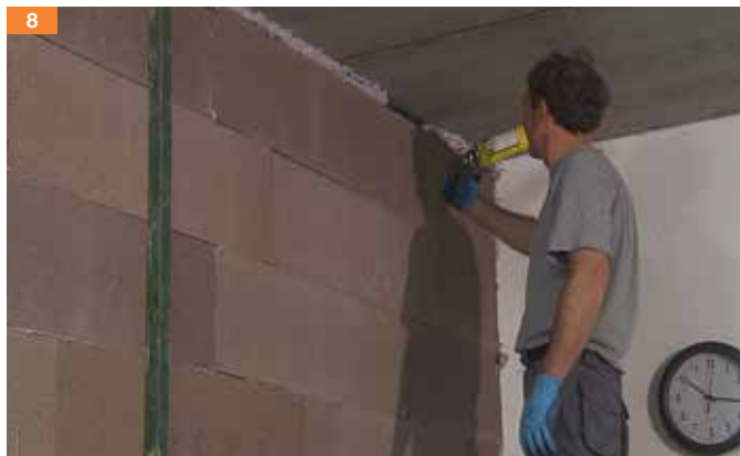
7-8. Stessa operazione di fissaggio avverrà in corrispondenza degli angolari a cerniera posti al soffitto. Con il collante Spidigliù verrà colmato lo spazio tra soffitto e parete su ambo i lati.
