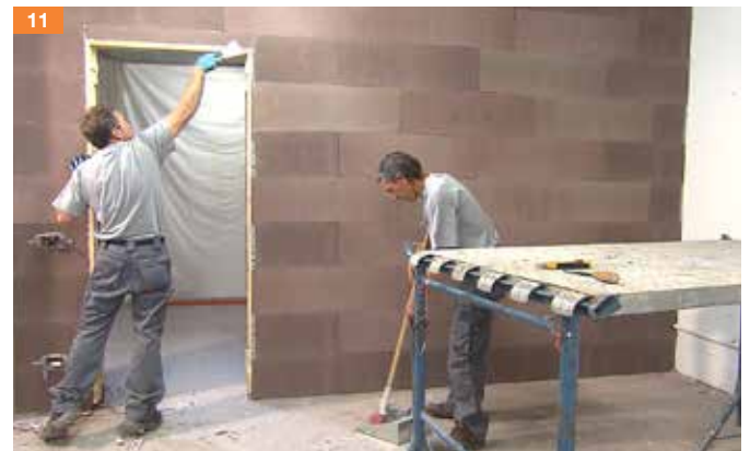
11. Pulizia della parete e dell'ambiente di posa.
