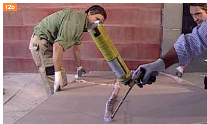
12b. Incollaggio della lastra in cartongesso con il collante Spidigliù. Applicare strisce di colla alla distanza di circa 30 cm una dall'altra.
