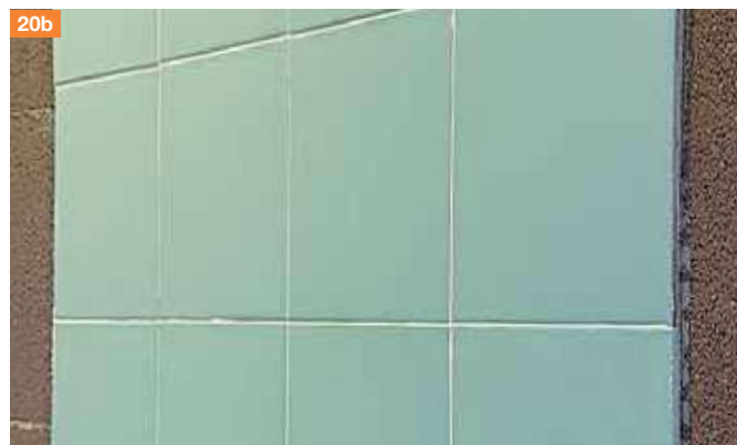
20b. Le piastrelle vanno applicate direttamente sulla parete Brik con i collanti P120-P180-P300.
