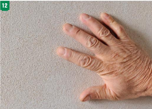
11.12. Per una finitura "a civile" la seconda mano di P180 può essere rifinita con il frattazzo a spugna prima dell'indurimento. Si ottiene una superficie piana e porosa che grazie alle palline di vetro è resa uniforme con semplici operazioni. Questa operazione può essere effettuata anche sulla prima mano se applicata a spessore.
