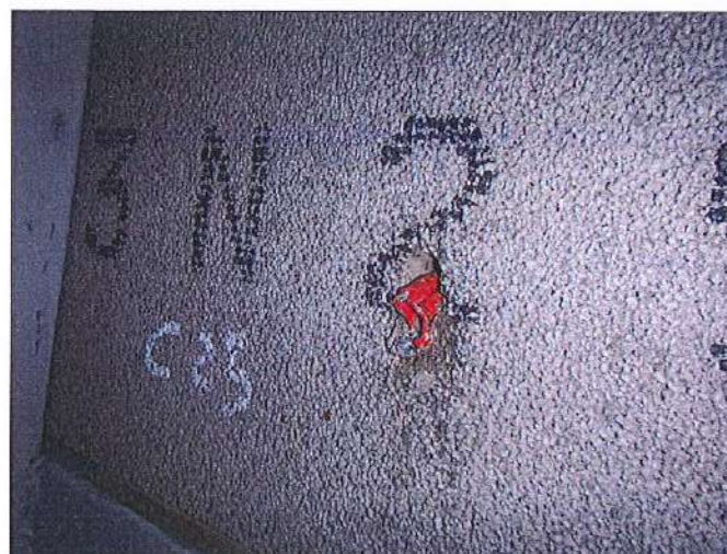
Fotografie di alcune rotture al termine della prova di taglio
