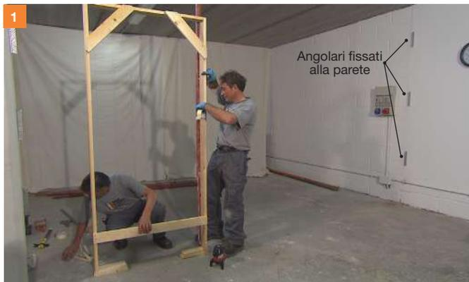
1. Posizionamento del contro telaio della porta e fissaggio con nastro adesivo ai calandri di posa, installazione degli eventuali angolari per il fissaggio della nuova parete alle strutture già esistenti.
