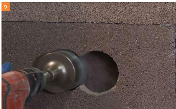
9. Foratura dei pannelli per l'inserimento delle scatole per l'impianto elettrico.
