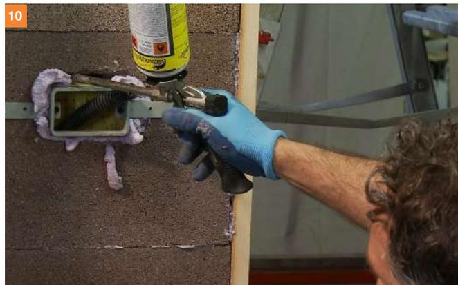
10. L'inserimento e fissaggio dei corrugati e delle scatole degli impianti.
