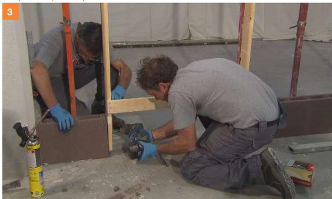
3. Fissaggio del contro telaio al primo corso di pannelli con le viti.
