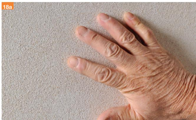
18a. Si può ottenere una finitura tipo "a civile" applicando una seconda mano con il rasante P180 sulla prima mano e verrà rifinito con il frattazzo a spugna prima dell'indurimento.
