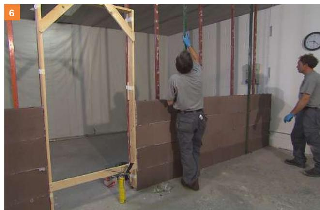
4-5-6. Il montaggio avviene alternando il senso di posa da sinistra verso destra e da destra verso sinistra ripetendo le operazioni di fissaggio del contro telaio e della parete alle strutture esistenti.
