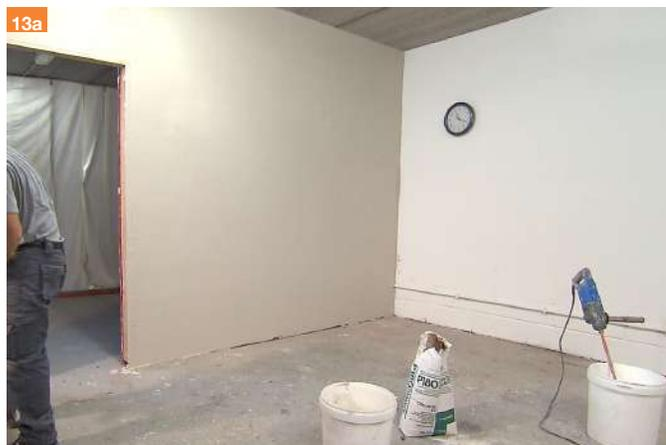
12a-13a Finita la posa ed effettuata la pulizia si procede subito alla rasatura delle pareti con il Collante Rasante P180 che va applicato con la spatola lunga in senso orizzontale sulla parete.
