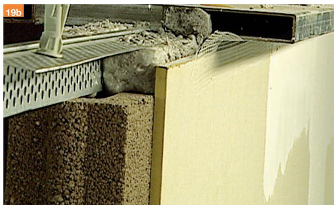
19b. Dispositivo in profilato di acciaio (angolare a cerniera) per l'ancoraggio al soffitto.
