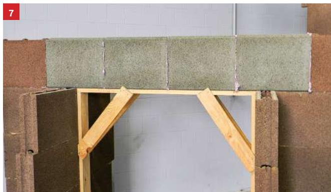
Compite le operazioni di posa (foto 7) anche a parete ultimata o comunque dopo che il collante abbia fatto presa, si pratteranno dei fori di 10 mm di diametro sulla prima costola dei pannelli nella mezzera e in corrispondenza della cavità contenente l'armatura (foto 8).
