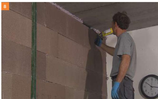
7-8. Stessa operazione di fissaggio avverrà in corrispondenza degli angolari a cerniera posti al soffitto. Con il collante Spidigliù verrà colmato lo spazio tra soffitto e parete su ambo i lati.
