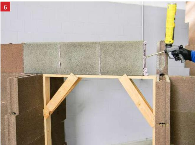
L'Archibravo in fase di realizzazione verrà sostenuto da elementi provvisori che verranno rimossi successivamente o dai controtelai degli infissi che rimarranno inseriti (foto 5). I pannelli verranno disposti in fila così che i fori orizzontali realizzino una o più cavità continue, meccanicamente uniti dal collante e allineati dai profili ad incastro dei pannelli stessi. I profili in acciaio preparati della lunghezza necessaria verranno inseriti nella o nelle cavità così ottenute (foto 6a e 6b).
