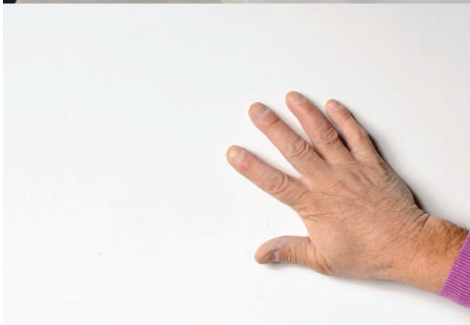
17. Per una “finitura liscia”, si passa sulla parete una mano di rasatura applicata con la spatola corta utilizzando il Rasante P190 .
