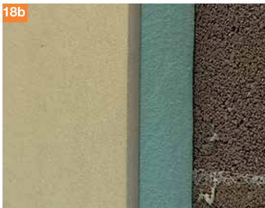
18b. Soluzione con lastra di cartongesso accoppiata con poliuretano per migliorare l'isolamento termico.
