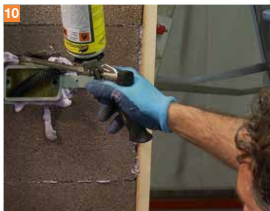
10. L'inserimento e fissaggio dei corrugati e delle scatole degli impianti.
