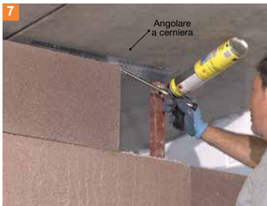
7-8. Stessa operazione di fissaggio avverrà in corrispondenza degli angolari a cerniera posti al soffitto. Con il collante Spidigliù verrà colmato lo spazio tra soffitto e parete su ambo i lati.
