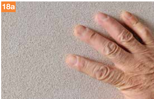
18a. Si può ottenere una finitura tipo "a civile" applicando una seconda mano con il rasante P180.2 sulla prima mano di P180. Il P180.2 va applicato nello spessore minimo di 1 mm e verrà rifinito con il frattazzo a spugna prima dell'indurimento.
