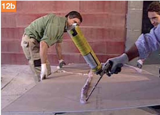
12b. Incollaggio della lastra in cartongesso con il collante Spidigliù.
