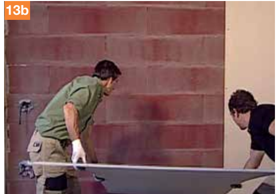
13b-14b. Applicazione delle lastre alla parete con il collante...
