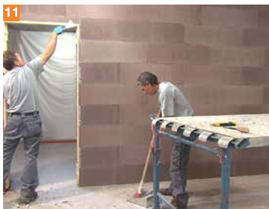
11. Pulizia della parete e dell'ambiente di posa.
