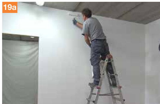
19a. La parete così preparata è pronta per ricevere la tinteggiatura.
