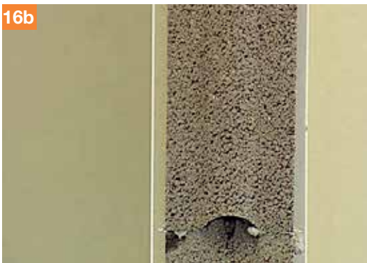
16b. Parete rifinita con lastre di mm 12.5 applicate in ambo i lati.
