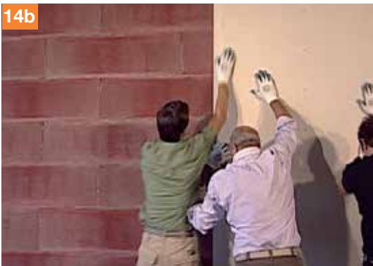
12b. Incollaggio della lastra in cartongesso con il collante Spidigliù.
