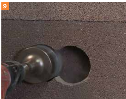
9. Foratura dei pannelli per l'inserimento delle scatole per l'impianto elettrico.
