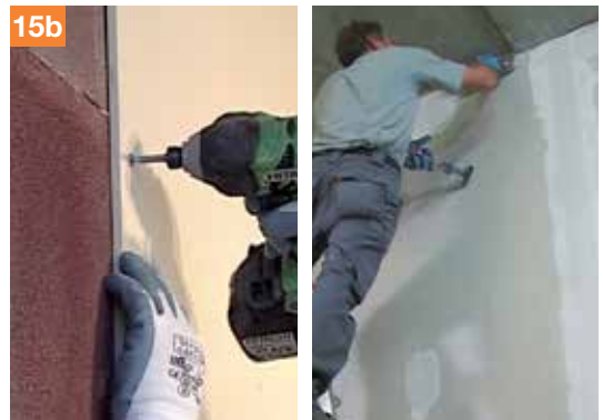
15b. ...e con le viti. Si procede poi con la stuccatura dei giunti.
