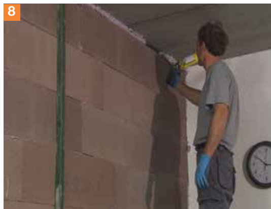
7-8. Stessa operazione di fissaggio avverrà in corrispondenza degli angolari a cerniera posti al soffitto. Con il collante Spidigliù verrà colmato lo spazio tra soffitto e parete su ambo i lati.
